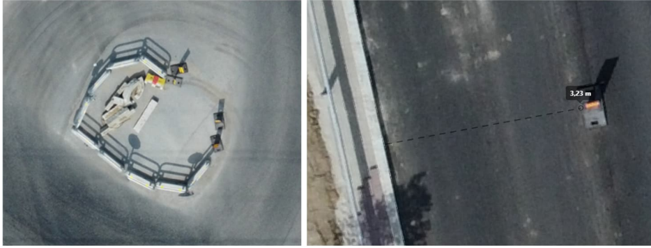
Kuva 10. Esimerkkejä ortokuvasta tehtävistä havainnoista. Vasemmalla on kuva tilapäisen liikenneympyrän mahdollisesti törmäyksen seurauksena hajonneesta keskiosasta. Oikealla on puolestaan ortokuvasta mitattu tilapäisen ajokaistan leveyttä (3.2 m).
