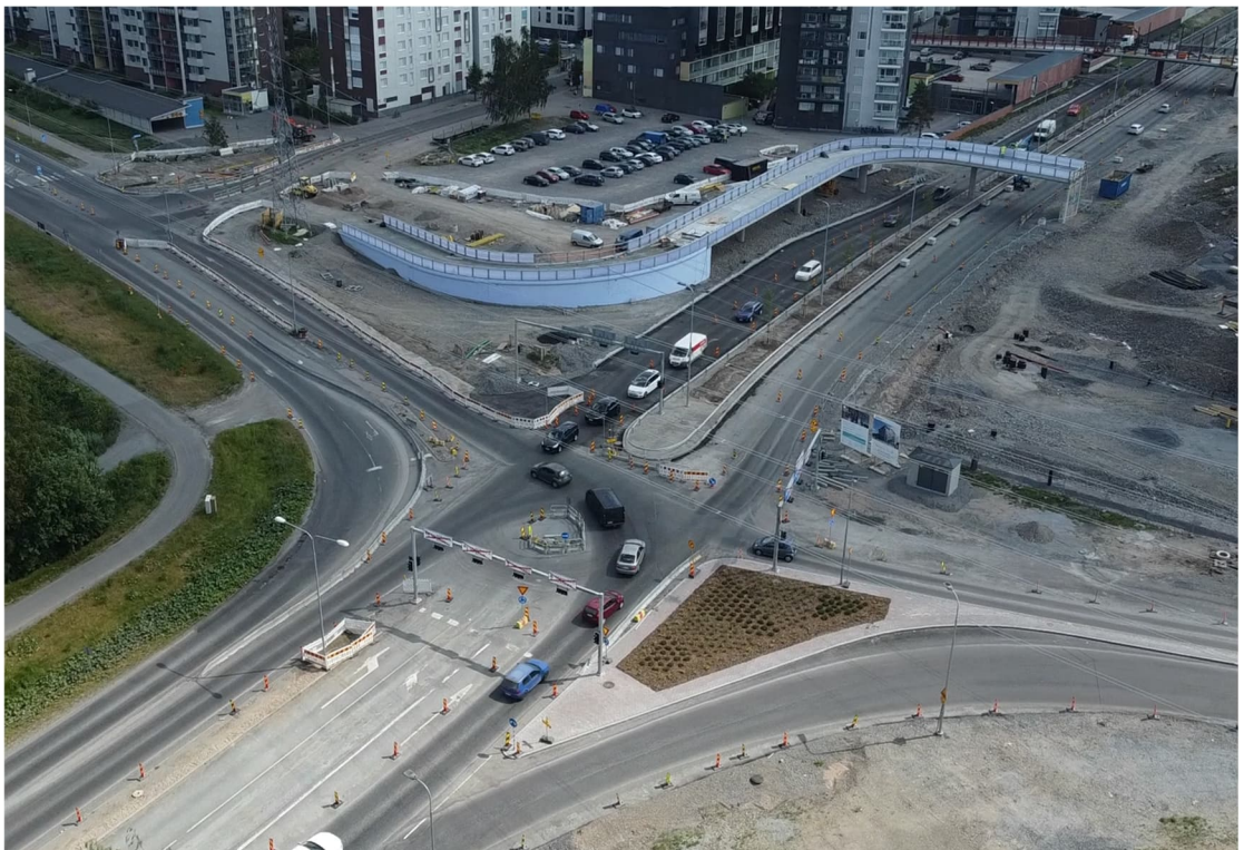
Kuva 11. Ruutukaappaus liikenteen videokuvauksesta. Esimerkissä on nähtävissä tilanne, jossa syntyi törmäysvaara. Liikenneympyrään etelästä päin (kuvassa ylhäältä) tuleva auto oli jo ajamassa ympyrään, mutta joutui nopeasti pysähtymään huomattuaan pohjoisesta (kuvassa alhaalta) tulevan auton kääntyvänkin kuvassa vasemmalle Ruskon suuntaan.
