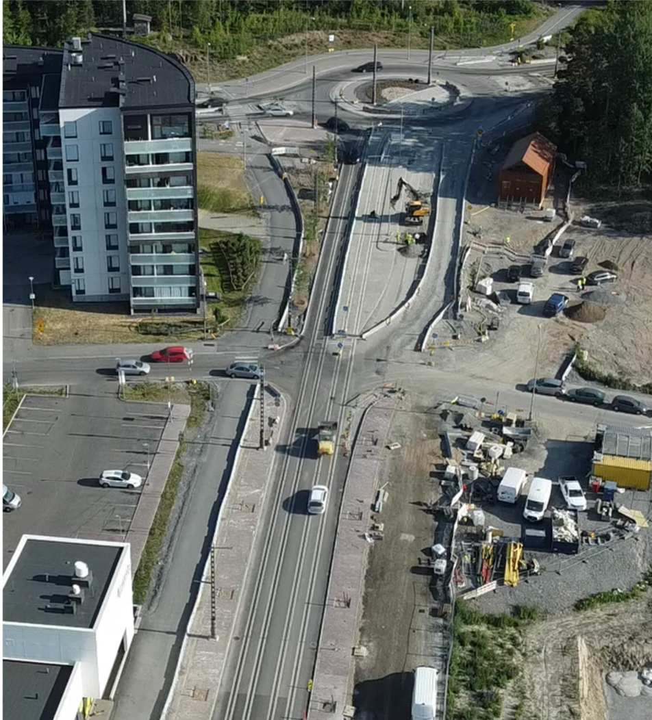
Kuva 8. Ruutukaappaus hitaasti rakennustyömaa-alueen läpi soljuvasta ajoneuvoliikenteestä. Aamuliikenteen ajoneuvotiheys oli juhannusviikon takia vähäinen.
