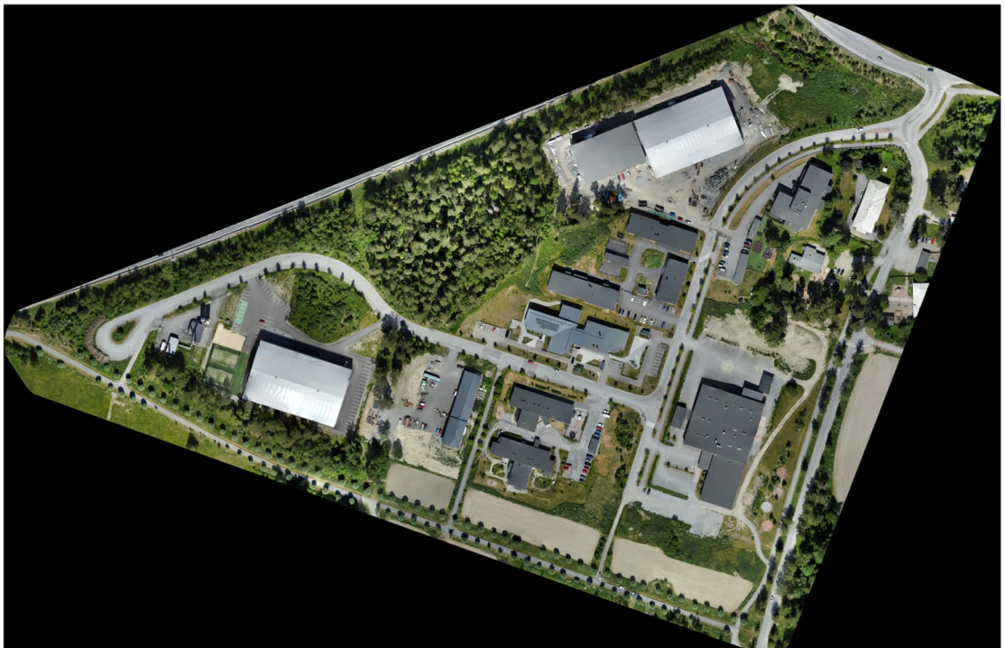
Kuva 7. Pitkäniemen alueesta laskettu ortokuva. Kartoitettu alue on 800 x 500 m, alueen pinta-ala on 0.2 km 2 .
