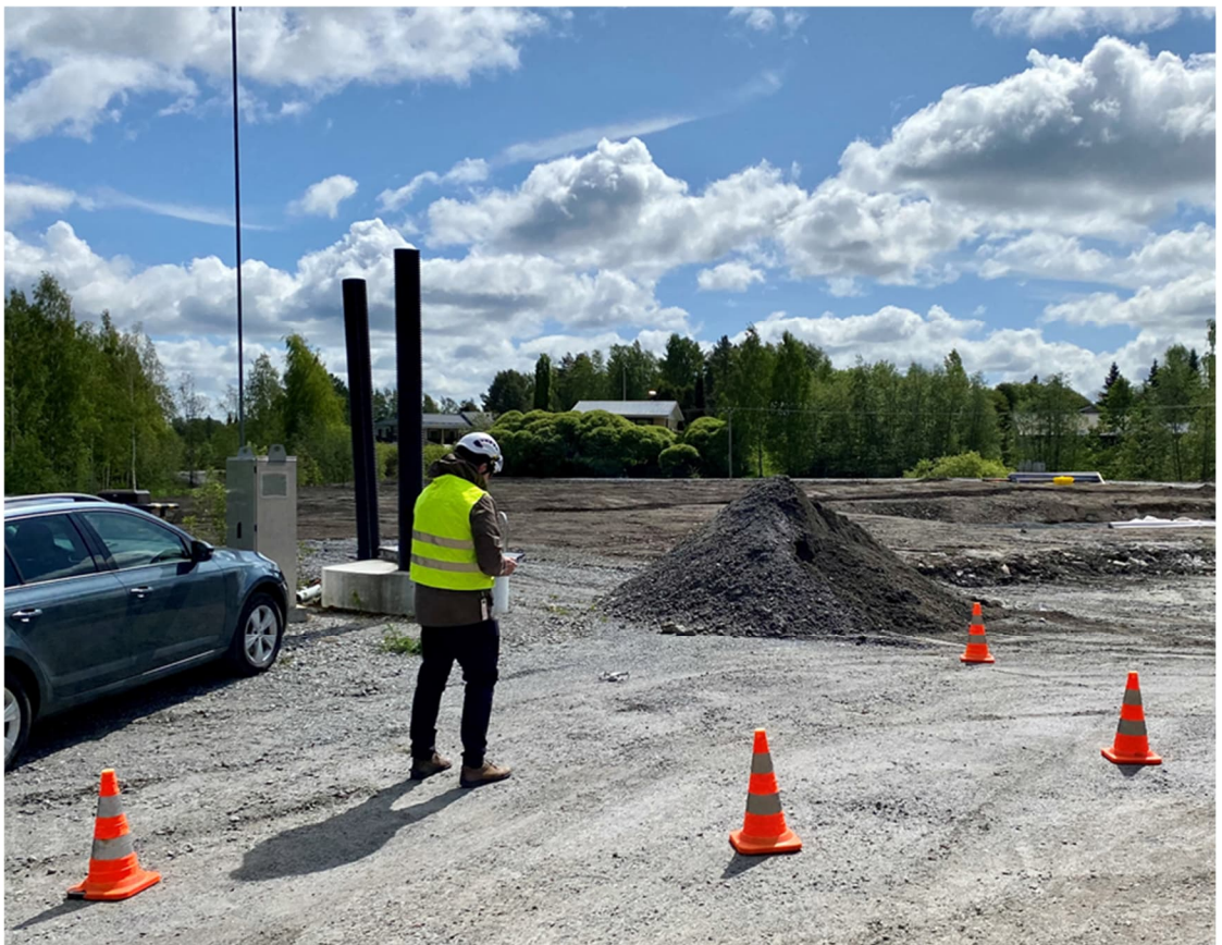
Kuva 4. Virtasalmen puiston ortokuvaus käynnissä.
